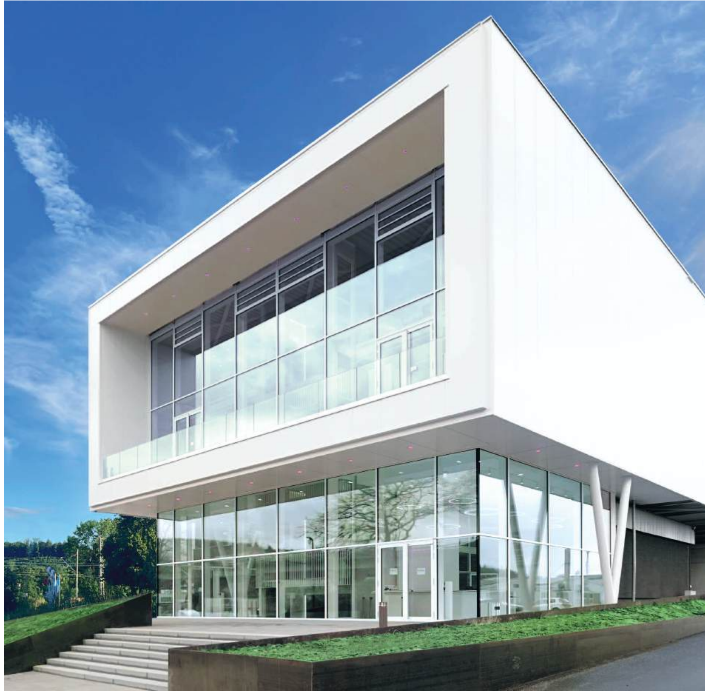
Der Baukörper schwebt über dem bestehenden Altbau und formuliert damit eine eigenständige architektonische Haltung: klar, zeitgenössisch und konstruktiv präzise Abb.: Neues Kunstmuseum Tübingen, Michael Kless
